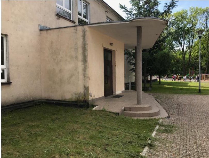
pawilon przeznaczony do rozbiórki
