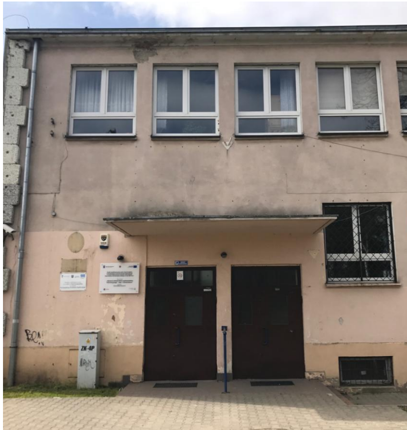
daszek wejściowy przeznaczony do rozbiórki
